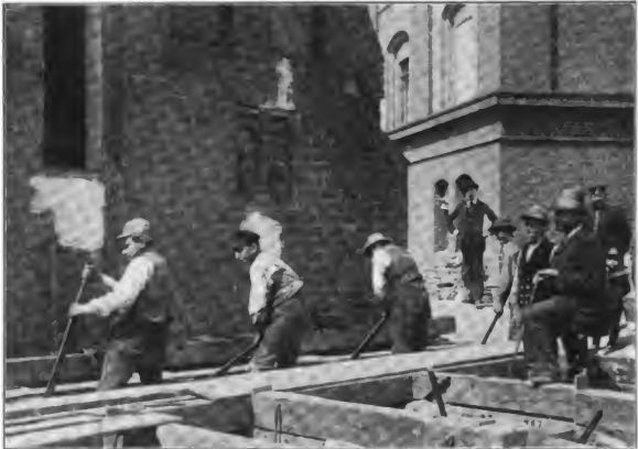
Abb. 30. Das Anziehen der Schrauben beim Verschieben der Jakobskapelle 1892.
